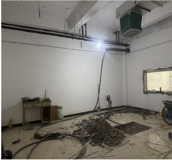
拟改造 DSA 机房
