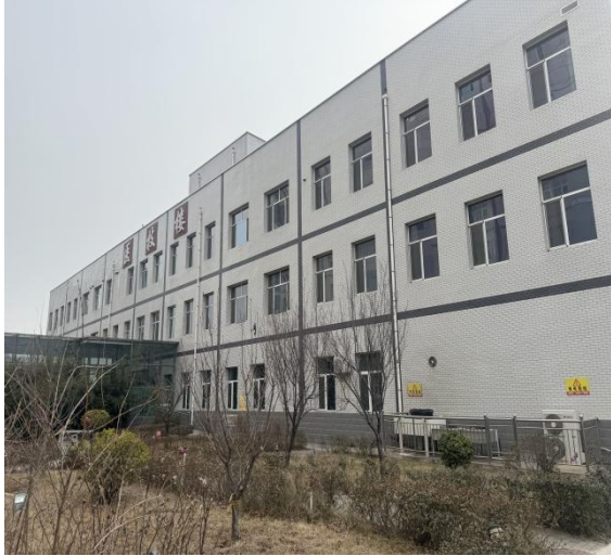
拟改造 DSA 机房所在医技楼
