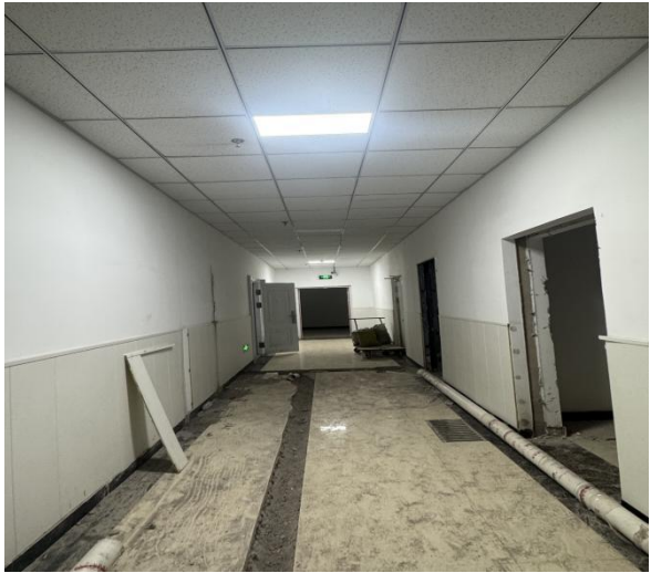
拟建机房北侧走廊
