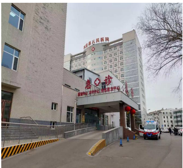
医技楼东南侧急诊楼
