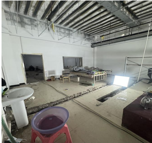
拟建机房西侧环境（操作室、设备间）
