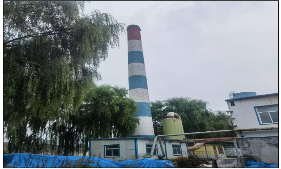
现有工程脱硫塔及煅烧烟气排气筒
