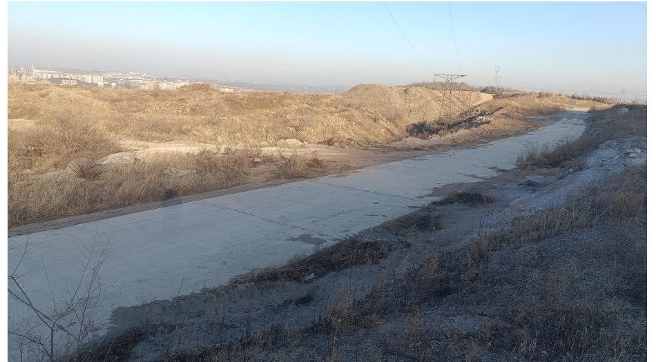
电站北侧道路
