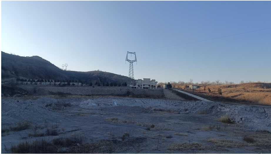
电站选址现状
